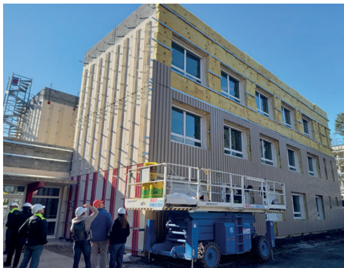
Rénovation du bâtiment de l'école Cap de Bos
